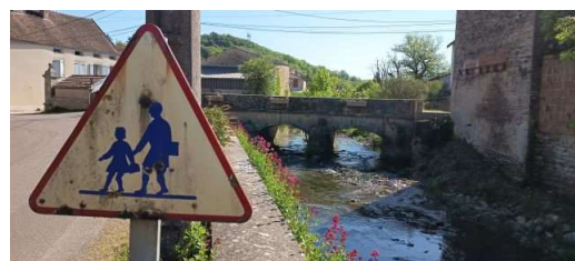
Pont qui enjambe Le Vau à Darcey
